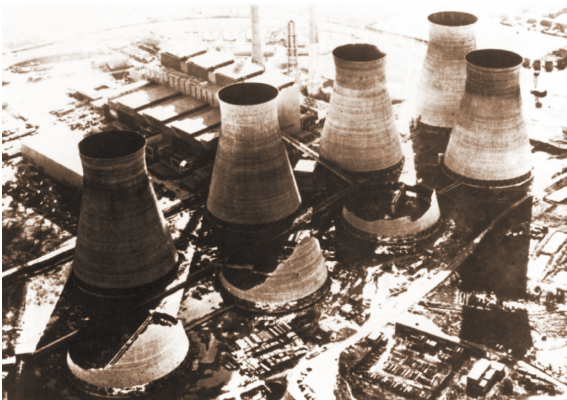
Rys. 2. Katastrofa trzech z ośmiu, ponad 100-metrowych żelbetowych chłodzi kominowych w Ferrybridge, Wielka Brytania. Zniszczeniu uległy chłodnie zawietrzne. Przyczyną katastrofy były zjawiska interferencji aerodynamicznej chłodzi zawietrznych z nawietrznymi o charakterze nieustalonym, które wywołały nadmierne drgania chłodzi zawietrznych [4]
