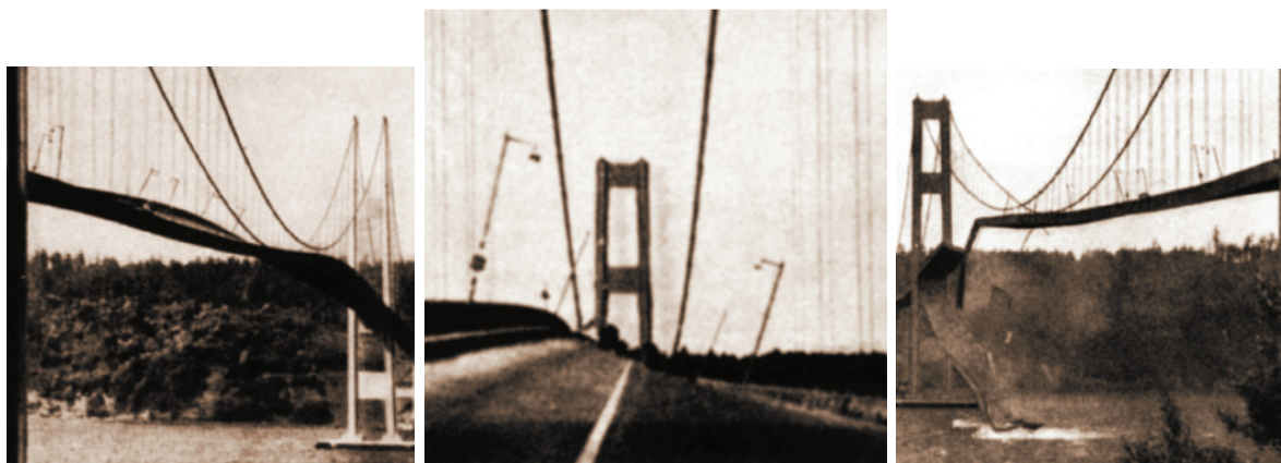
Rys. 3. Katastrofa mostu wiszącego w Tacoma Narrows, blisko Seattle, USA, w wyniku flutteru giętno-skrętnego przęsła mostu przy silnym wietrze (1940 r.) [4]
